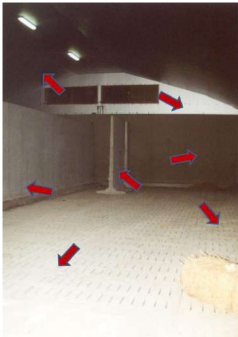
Abbildung 2 – Bereiche des Lagers, an denen eine CIPC-Kontamination leicht nachgewiesen werden kann
