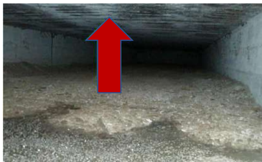
Abbildung 4 - Unterflurkanal mit losen Schmutzpartikeln und CIPC-Rückständen
