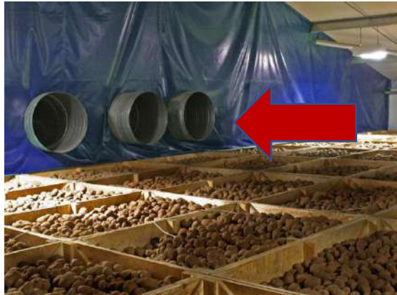
Abbildung 5&6 Belüftungs- und Kühltechnik mit Luftverteilereinrichtung im Kistenlager
